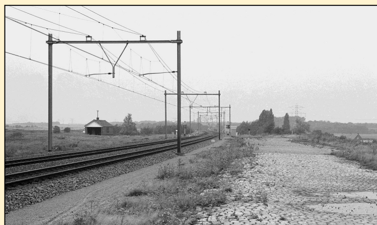
Gezicht in noordelijke richting vanaf de plek van het vroegere stationsgebouw Woensdrecht. Links staat het gebouwtje van Weg & Werken uit 1950, en rechts onderaan het talud (buiten beeld) liggen de dienstwoningen uit 1947. Bij de overweg stond wachterswoning 16. Foto Marius Broos, 18 augustus 1987.
