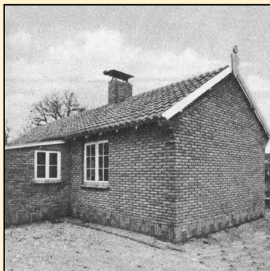
Linksboven: Achterzijde woning met slaapkamer en keuken in de uitbouw.
