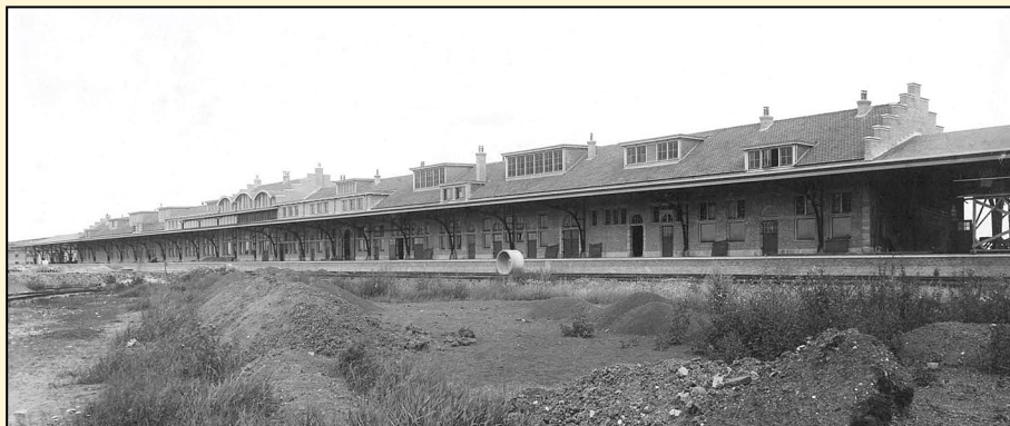
Het nieuwe stationsgebouw van de SS te Baarle Nassau (grens) kwam in 1906 gereed. Foto, collectie Marius Broos.
