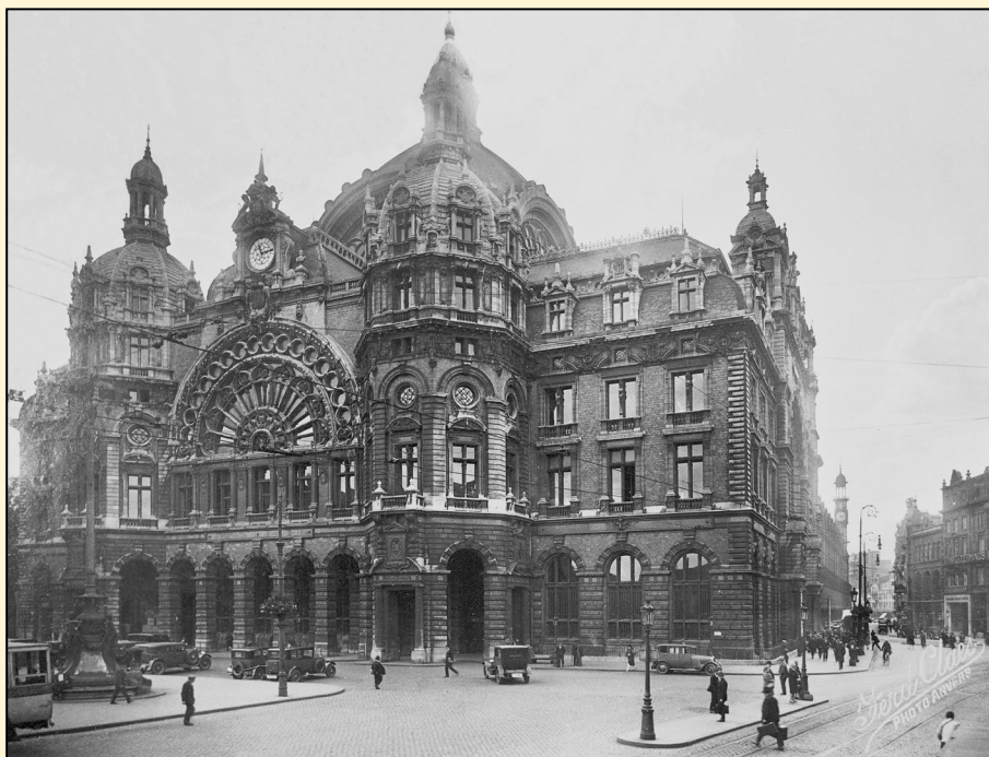
Straatzijde van het stationsgebouw 'van de 'Etat Belge', gebouwd in de jaren 1895-1905 naar een ontwerp van architect Louis de la Censerie, te Antwerpen. Foto uit 1938, collectie Marius Broos.
