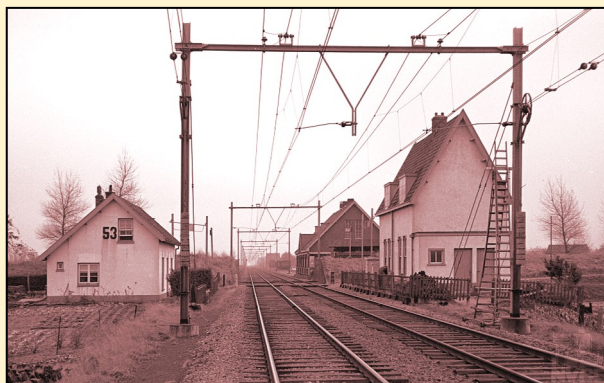
Gezicht vanuit het westen op wachterswoning 53 (links), het haltegebouw uit 1902 (rechts) en het haltegebouw uit 1914 te Lewedorp. Foto Roef Ankersmit, circa 1960, collectie NVBS.
