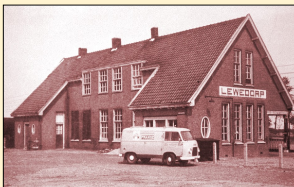
Gezicht vanuit het zuidoosten op de straatzijde van het haltegebouw van Lewedorp. Het was een voor dit dorp uit de kluiten gewassen gebouw. Foto uit circa 1960, collectie Marius Broos.
