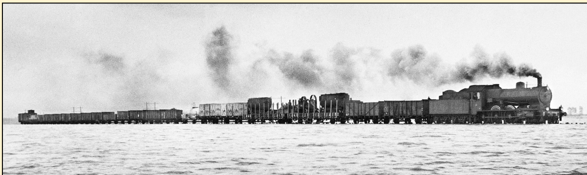
Locomotief NS 3704 rijdt met een goederentrein over de 'badkuipspoorweg' in de Kruijningerpolder.
