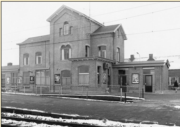
Gezicht op de perronzijde van het stationsgebouw te Kruiningen-Yerseke. Foto uit de jaren zeventig, collectie Marius Broos.
