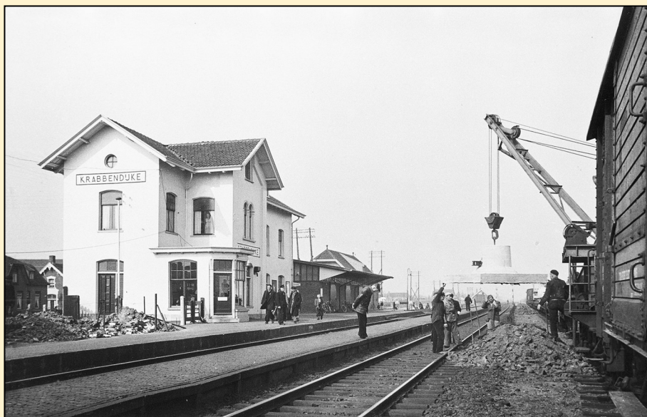
De elektrificatie van de Zeeuwse lijn begon in 1956 met het plaatsen van portaal-mastvoeten en het opruimen van in de weg staande objecten op de stations, zoals in Krabbendijke. Foto NS, 3 april 1956, collectie Marius Broos.
