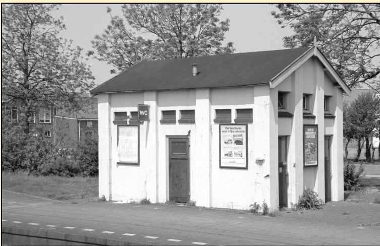
Het retiradegebouw werd gebouwd in 1865 en gesloopt in 1990. Foto Marius Broos, 13 mei 1988.
