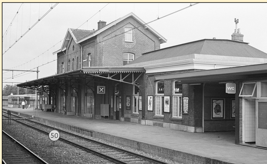
In het stationsgebouw Goes lag de wachtkamer 1 e en 2 e klasse, en ook de wachtkamer 'Niet Rookten' (destijds speciaal bestemd voor dames van de betere stand) aan de oostzijde. Goes was nog een echt stadje. Duidelijk is de dakconstructie te zien boven de wachtkamers te zien: een in het midden afgeplat schilddak. Het gebouw verdiende ongetwijfeld een monumentenstatus. Foto Marius Broos, 31 juli 1976.
