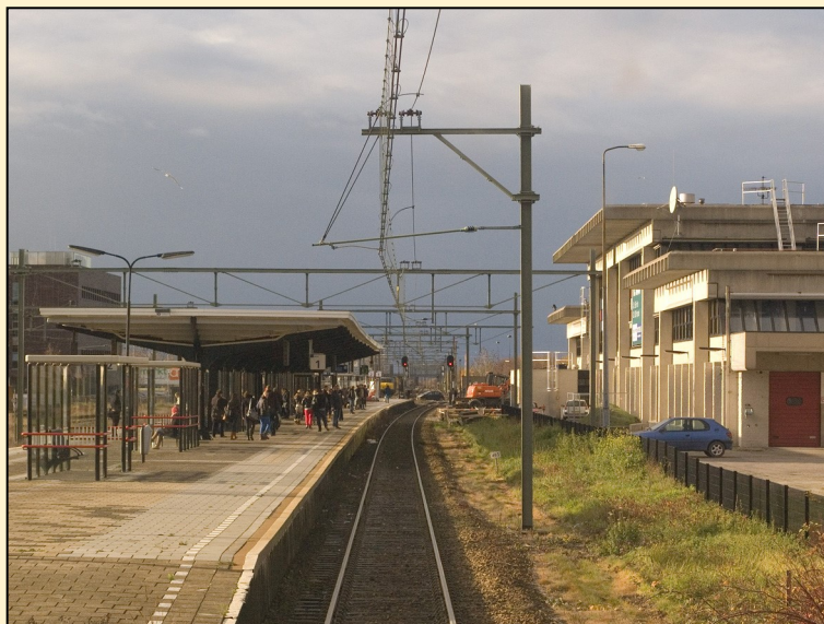
Zelfs een plotseling doorbrekend novemberzonnetje kan niets aan de naargeestige stationsomgeving van Goes veranderen. Goes is aan de Zeeuwse lijn niet meer dan een halte. Het 'stationsgebouw' uit 1982 is slechts een 'utiliteitsbouw' naast 'het spoor'. Alleen de twee brede bovenleidingsportalen met het voetstuk buiten de afrastering geven nog de plaats aan van het vroegere stationsgebouw en het (eerste) perron. De overkapping op het (tweede) perron is bijna een eeuw oud. Gezicht vanuit de cabine van trein IC 2137 (Amsterdam Centraal - Vlissingen). Foto Marius Broos, 29 november 2012.
