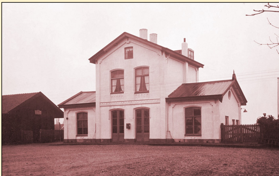
Straatzijde stationsgebouw Arnemuiden, 5 november 1953. Aan weerszijden van het hoge deel zijn aan de regenafvoerpijpen piramidevormige ombouwen aangebracht, zodat onverlaten die hoeken niet als urinoir kunnen gebruiken. Foto, collectie Het Utrechts Archief, Utrecht.
