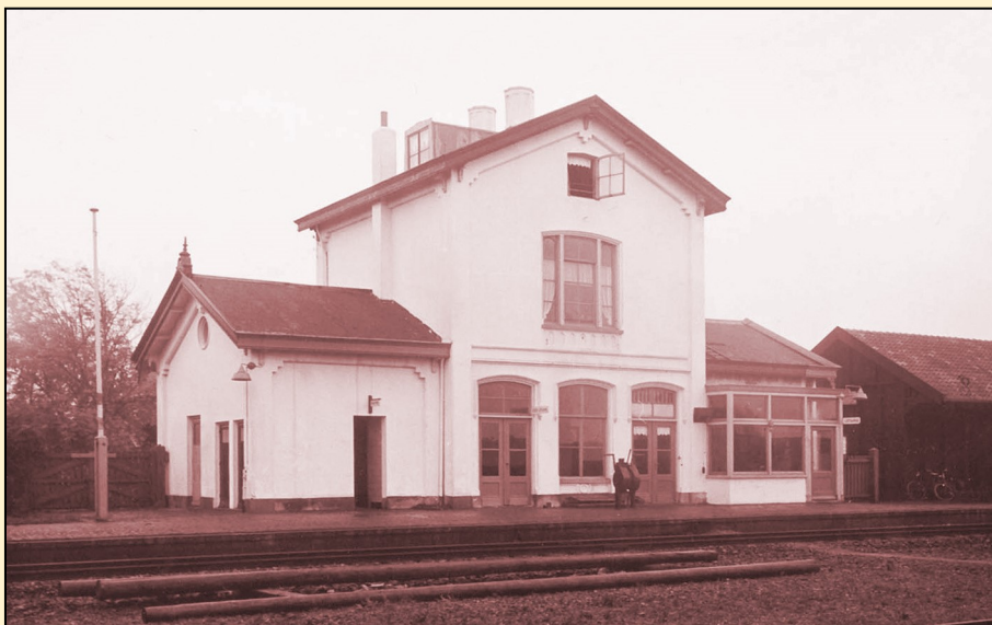
Perronzijde stationsgebouw Arnemuiden, 5 november 1953. Op het perron staat de handelinrichting voor de sluitbomen van de nabijgelegen overweg. Rechts daarvan ligt de uitbouw voor de treindiensleider, daterend uit circa 1930, en de houten goederenbergplaats uit circa 1875. Foto, collectie Het Utrechts Archief, Utrecht.
