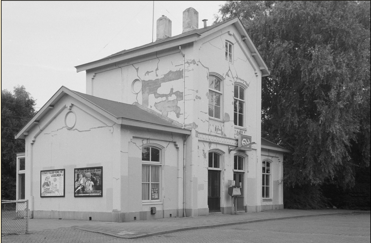
In de jaren tachtig lijkt het einde van het stationsgebouw Arnemuiden erg nabij. Het plaatskaartenkantoor wordt gesloten en het gebouw komt in vervallen toestand. Toch is de redding al in aantocht. Foto Marius Broos, 30 augustus 1988.
